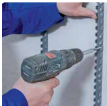
Uponor Minitec einfach montiert – mit den praktischen Uponor Fix Klemmschienen.
