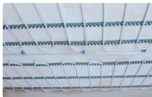
Uponor Minitec ist auch als Deckenheizung/-kühlung einsetzbar.
